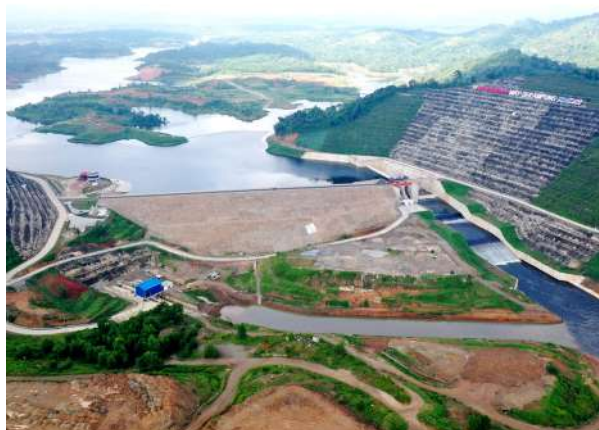
Bendungan Way Sekampung yang berfungsi mengairi 72.707 Ha lahan irigasi di Provinsi Lampung.
