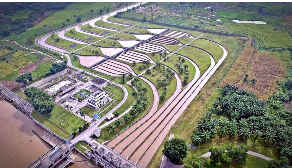
Bendung Perjaya merupakan bagian dari prasarana jaringan irigasi Komering di Sumatera Selatan.
