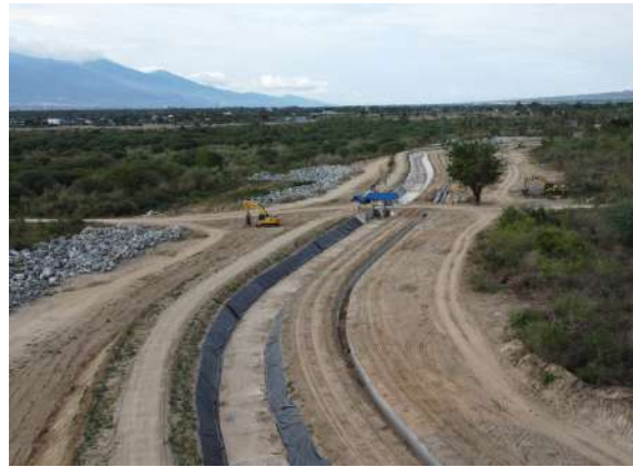
Rehabilitasi jaringan irigasi Gumbasa Pasca Bencana Gempa Sulawesi Tengah.
